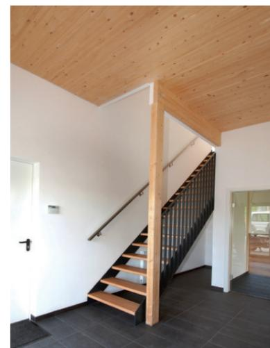
fertiggestellt. Das komplette Tragwerk ist aus Brettschichtholz, inklusive eingespannter Stützen. Die Wohnung kann sich sehen lassen: Großformatige Fensterelemente machen die Wohnung hell
