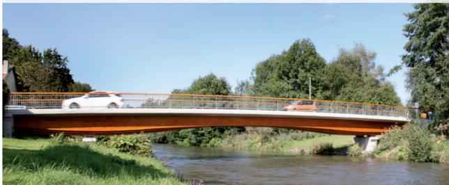
auch optisch innovative Holz-Beton-Verbundbrücke über den Fluss. Die Brücke reizt die statischen Eigenschaften der beiden Baustoffe Holz und Beton optimal aus. In der überwiegenden Druckzone der Brücke ist eine Betonplatte als Fahrbahn angeordnet. Das Holz ist als Hauptträger in der Zugzone eingesetzt. „Dadurch wird vom Holz ein beachtlicher Teil der
