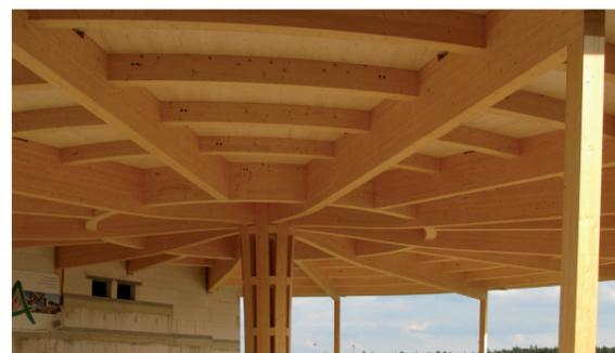
Die Dachschalung besteht aus Brettspertholz. Die Dachelemente wurden als „Tortenstücke“ zugeschnitten und treffen sich am Königsstil in der Tragwerksmitte.
